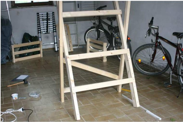
Schnell sind die beiden Seitenelemente erstellt und man kann die Teile zur Scherenleiter zusammenfügen.
